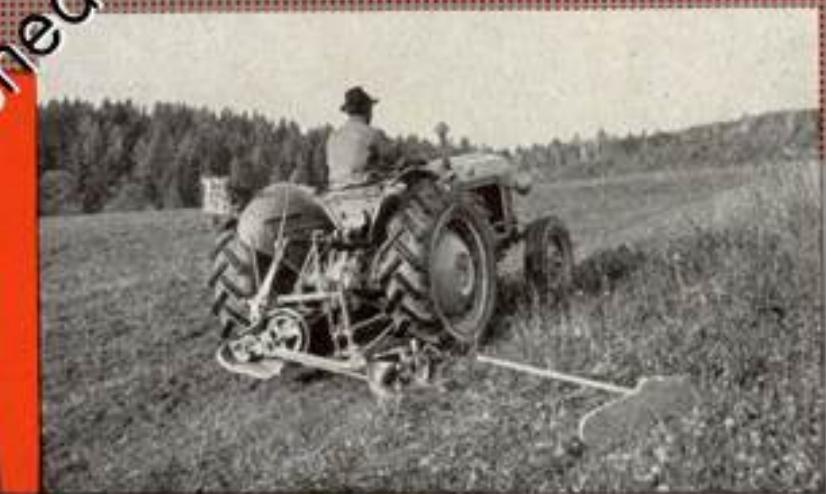
▲ **FERGUSON-HECKMÄHWERKE** arbeiten selbst auf sehr hängigem Gelände einwandfrei und zeichnen sich durch einmalige Materialgüte aus. Breite des Mähbalkens wahlweise 1,50 m bzw. 1,80 m. Schneller Auf- und Abbau, der Traktor behält für alle anderen Arbeiten seine ganze Bodenfreiheit.
