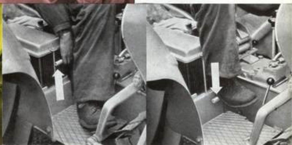
Die serienmäßig eingebaute Differentialsperre kann sowohl mit der Hand betätigt werden, indem der Fahrer den Hebel nach oben zieht, als auch mit dem Fuß, wobei der Hebel nach unten getreten wird. So kann der Fahrer jederzeit die am günstigsten erscheinende Bedienungsart der Differentialsperre wählen.
